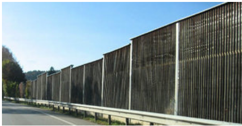
Einige Anwohner der Bahnstrecke zwischen Hergatz und Lindau dürfen auf Lärmschutz hoffen. (Foto: oh)
